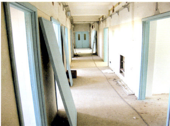
As instalações do Serviço de Medicina Paliativa do Centro Hospitalar da Cova da Beira estão a ser alvo de obras de melhoramento e ampliação. Serão criados cinco quartos individuais.
